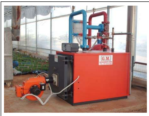
Fig. 1 – Caldaia a gasolio per il riscaldamento delle serre.
